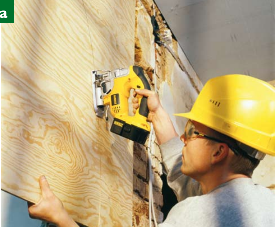
Przy tego rodzaju zadaniach ręczna wyrzynarka elektryczna jest praktycznie rozwiązaniem jedynym, a jej wersja akumulatorowa – optymalnym.
